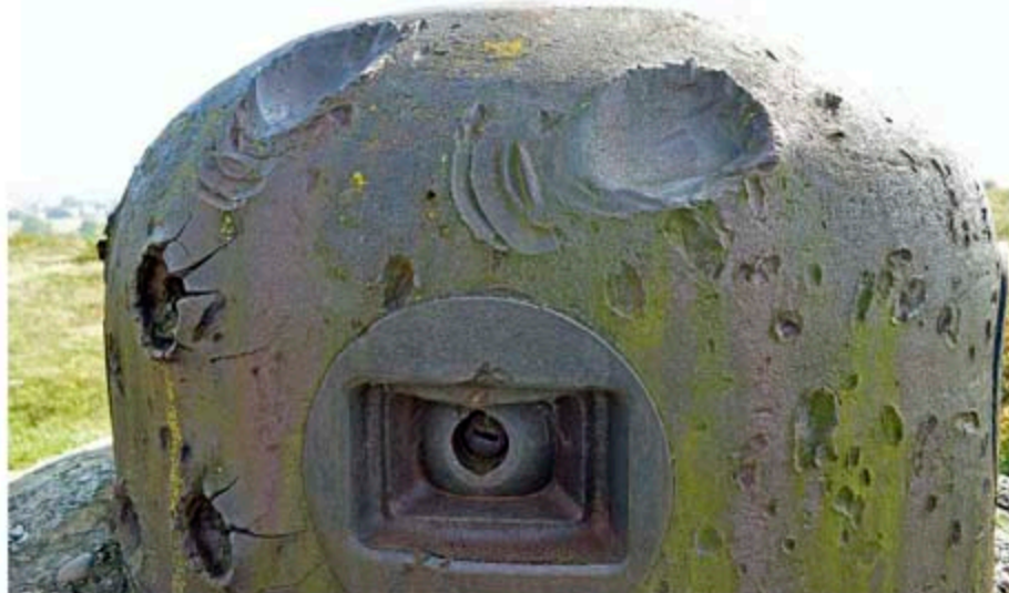
➤ Les impacts d'obus Flak de 88mm sur le cuirassement sont nettement visibles.
