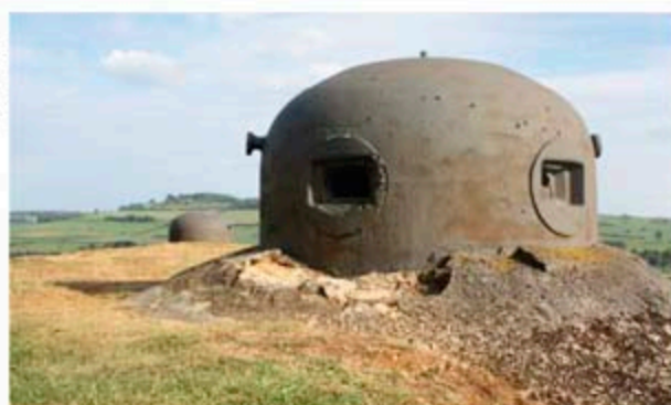
↘ Dessus du bloc 1. Le créneau de gauche de la cloche de tir a été détruit par une charge explosive.
