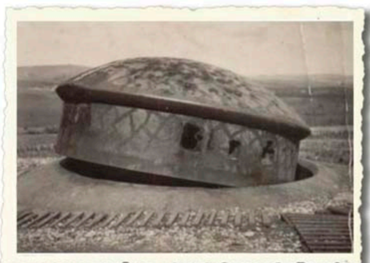
➤ La tourelle à éclipse du bloc 2, détruite par une charge explosive de 40 kgs. On voit nettement la peinture de camouflage sur le côté gauche.
