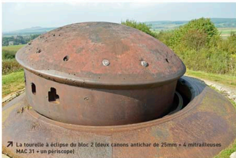
➤ Les impacts d'obus Flak de 88mm sur le cuirassement sont nettement visibles.
